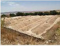
El segundo conjunto, las *cisternas de Aïn Mizeb*, se halla en un buen estado de conservación. Situadas cerca del templo de Minerva, sus ocho cisternas abovedadas, pueden llegar a almacenar hasta 9 000 m<sup>3</sup>, e incluyen un estanque de decantación. Estas cisternas se alimentan de una fuente situada a 200 m. y de un acueducto subterráneo<sup>1</sup>.
